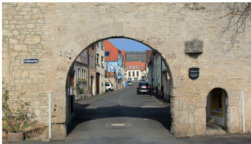
Maintor mit den Hochwassermarkierungen seit 1552
