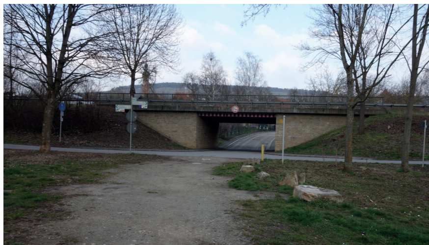
Durchgang unter der B13 hindurch, Verbindung zwischen Altstadt und Main
