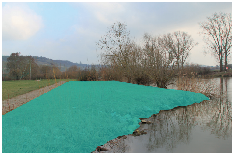
Einbuchtung im Rückbereich der Schiffsanlegestelle
