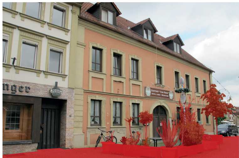
Materialmix, Vorbereich des Gasthofs zum Roß
