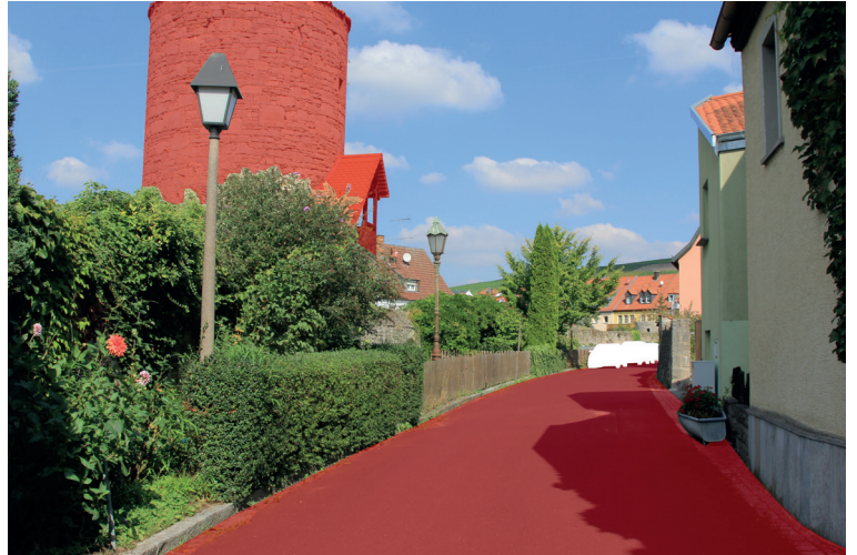
Mauerring mit Turm und Gärten
