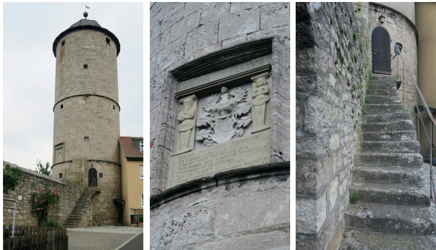
Turm Nr.1 - innerhalb der Stadtmauer
