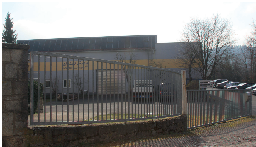
Gewerbe- und Industriebauten am Rande der Altstadt
