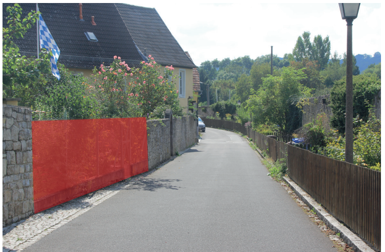
Natursteinmauer Räumliche Fassung des "Unteren Grabens"
