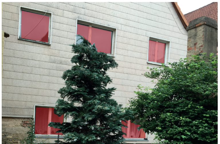
Leer stehendes Gebäude am Heumarkt
