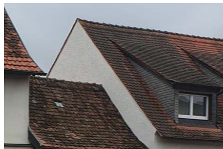
Abb. 3: positives Beispiel für Ortgangausbildung ohne Dachüberstand und gemauertem, verputztem Giebel
